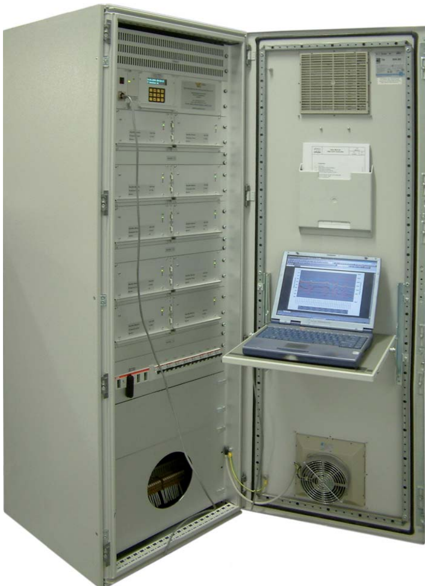
Abb. 7: Der V&C KKS-Kontroller: Automatisch regelnder Schutzgleichrichter mit Remote Control
