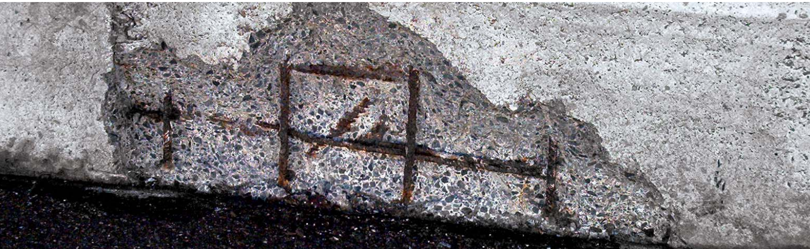
Abb. 1: Einflussfaktoren auf das Korrosionsrisiko der Bewehrung im Stahlbeton
